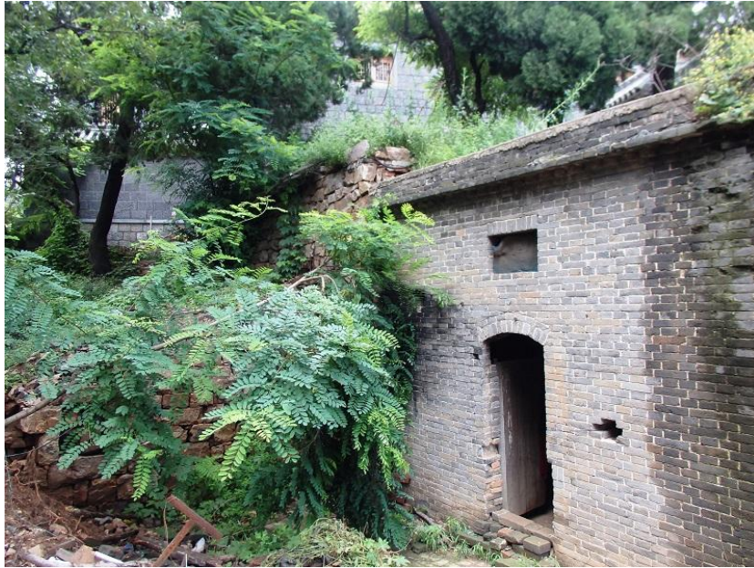
Fot. 31. Jedyną widoczną pozostałością po dawnych zabudowaniach klasztoru Er Zu jest przylegający do jego muru niewielki, opuszczony budynek, powyżej którego wznoszą się ściany nowo budowanej świątyni (fot. autor, 2016 r.).
